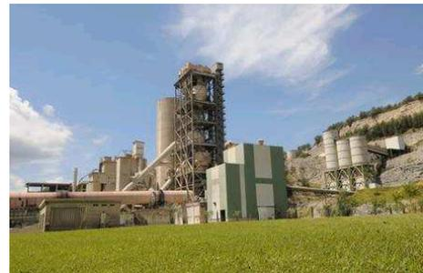
*Le process cimentier est un process industriel à feu continu, nécessitant une grande quantité d'énergie thermique et électrique. L'énergie électrique est majoritairement utilisée pour la préparation et le broyage des matières et l'énergie thermique est requise pour la réaction de transformation minéralogique de la matière.*
